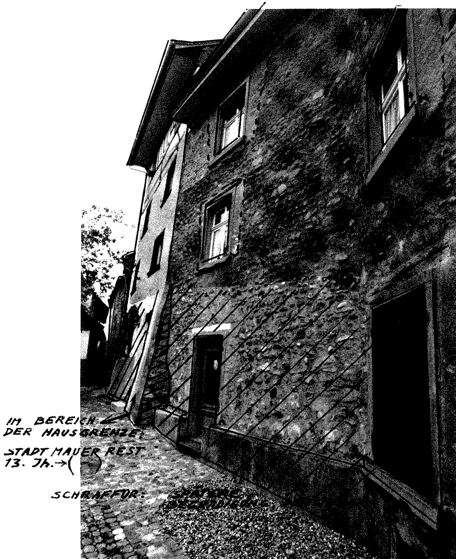
Abb. 16. Am Rosengässlein, im Vordergrund Nordwand des Hauses Zur Zinne mit Resten der Stadtmauer aus der Gründungszeit der Stadt. Der merkwürdige Fassadenknick weist auf ein Stadttor hin, das im 13. Jahrhundert wahrscheinlich an der Stelle der heutigen Treppe (Standort des Fotografen) lag. Diese Torbaute war wohl auf den Weg zur Brücke ausgerichtet und deshalb schräg in die Nordfront gesetzt.
