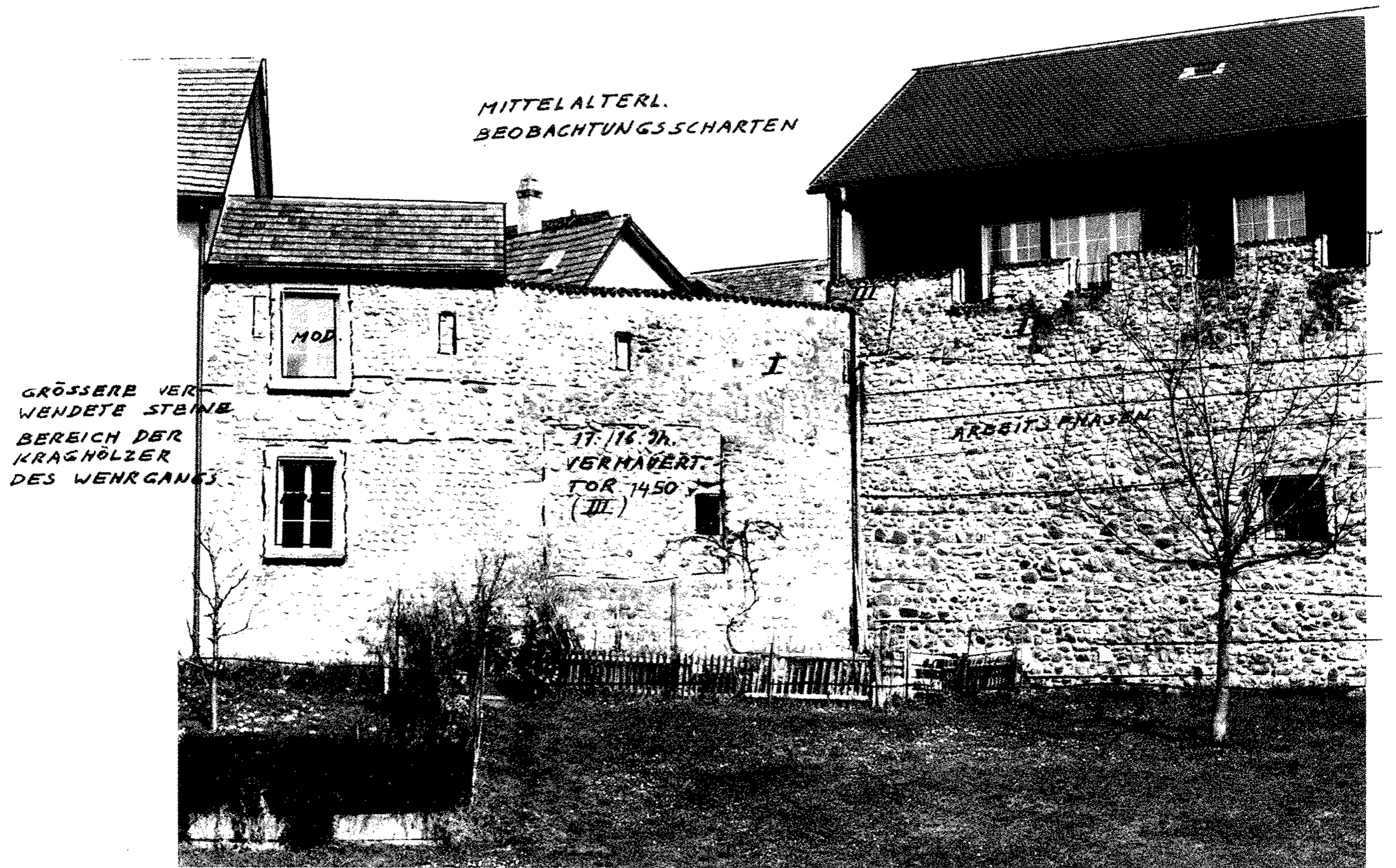
Abb. 14. Stadtmauerstück südlich des Siegelturms. Übergang von der Ummauerung der Gründungstadt (12./13. Jahrhundert; linke Bildhälfte, charakteristische Ansätze eines Ährenverbandes) zur Erweiterung des Stadtmantels (14. Jahrhundert; rechte Bildhälfte).
