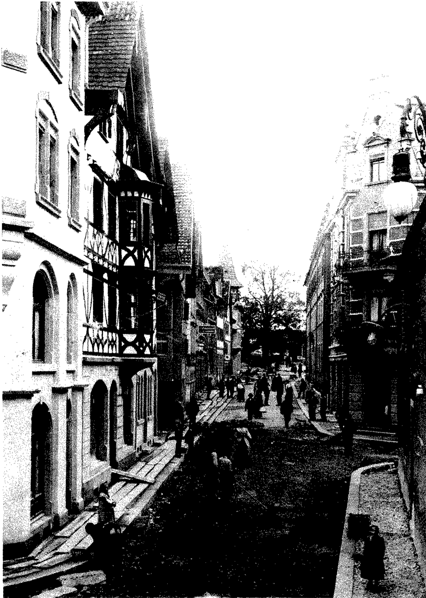
Abb. 25: 1902 schritt die Behörde zum Ausbau der Hauptverkehrsachse durch das Städtchen. Die Hauptstrasse erhielt eine Gross-Steinpflasterung gegen Staub- und Morastbildung und Trottoirs für die Fussgänger. Foto 1902.
